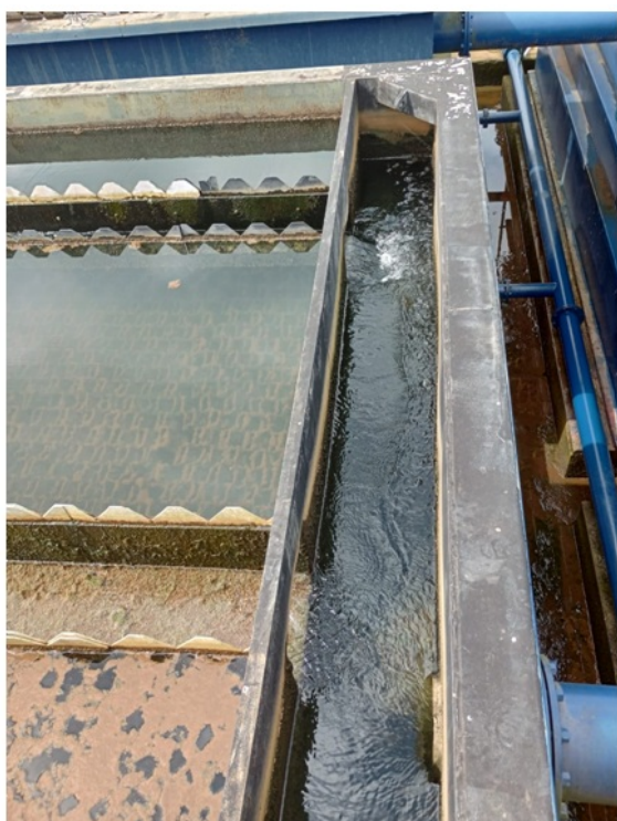
Foto 10 e 11 – Recebendo despejo de um dos floculadores, dois decantadores sedimentam estes flocos e a água decantada vai para quatro filtros que compõem este módulo de tratamento. A limpeza manual dos decantadores acontece semanalmente segundo os operadores, e o lodo vai para GAP.
