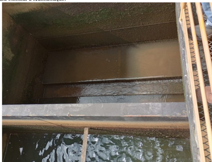
Foto 13 a 14 – Filtros ( quatro por módulo de tratamento) de areia e antracito que recebem a água decantada e a filtram por gravidade. Os filtros duas vezes por dia são limpos por retrolavagem, também por ação da gravidade.,com acionamento de válvula.
