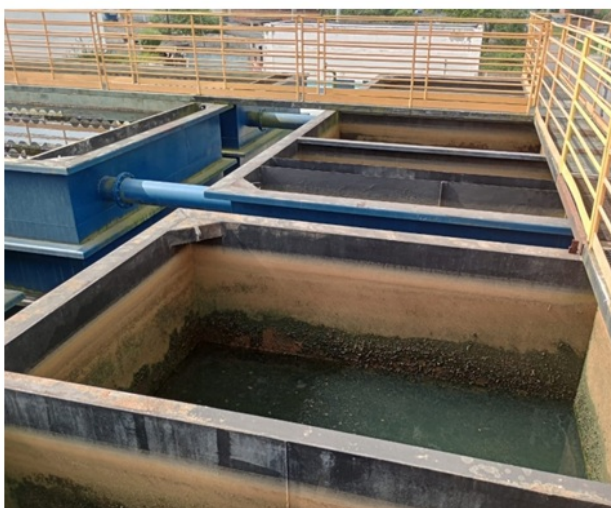
Foto 13 a 14 – Filtros ( quatro por módulo de tratamento) de areia e antracito que recebem a água decantada e a filtram por gravidade. Os filtros duas vezes por dia são limpos por retrolavagem, também por ação da gravidade.,com acionamento de válvula.
