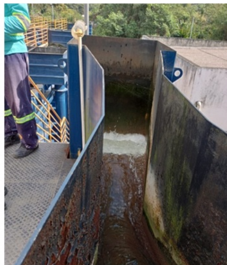
Foto 6 e 7 – Lançamento de sulfato de alumínio (despejo da mangueira azul) no canal de descarga do reservatório de água bruta, após dosagem na casa de química ,onde acontece mistura rápida com vortex no final do canal.. A partir deste ponto inicia-se a coagulação com a quebra da estabilidade das suspensões coloidais.
