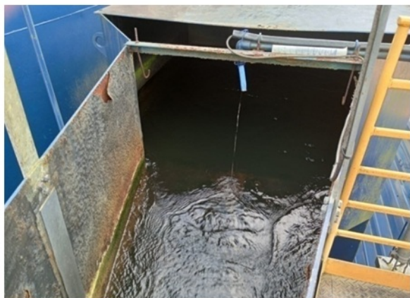
Foto 6 e 7 – Lançamento de sulfato de alumínio (despejo da mangueira azul) no canal de descarga do reservatório de água bruta, após dosagem na casa de química ,onde acontece mistura rápida com vortex no final do canal.. A partir deste ponto inicia-se a coagulação com a quebra da estabilidade das suspensões coloidais.
