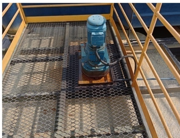
Foto 8 e 9 - No floculador com a colisão das partículas desestabilizadas favorecendo a sua agregação em flocos, através de uma mistura lenta com misturadores de baixa rotação (motores azuis) , os flocos vão para a próxima inidade.
