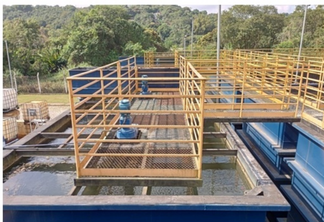
Foto 8 e 9 - No floculador com a colisão das partículas desestabilizadas favorecendo a sua agregação em flocos, através de uma mistura lenta com misturadores de baixa rotação (motores azuis) , os flocos vão para a próxima inidade.
