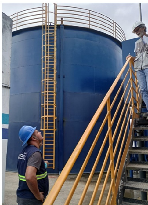
Foto 4 e 5 – Reservatório de Água Bruta com escada de marinheiro e guarda corpo; Escada de acesso e passarela ao longo dos módulos de tratamento, ambos com guarda corpo e chapa vazada do piso em bom estado de conservação.
